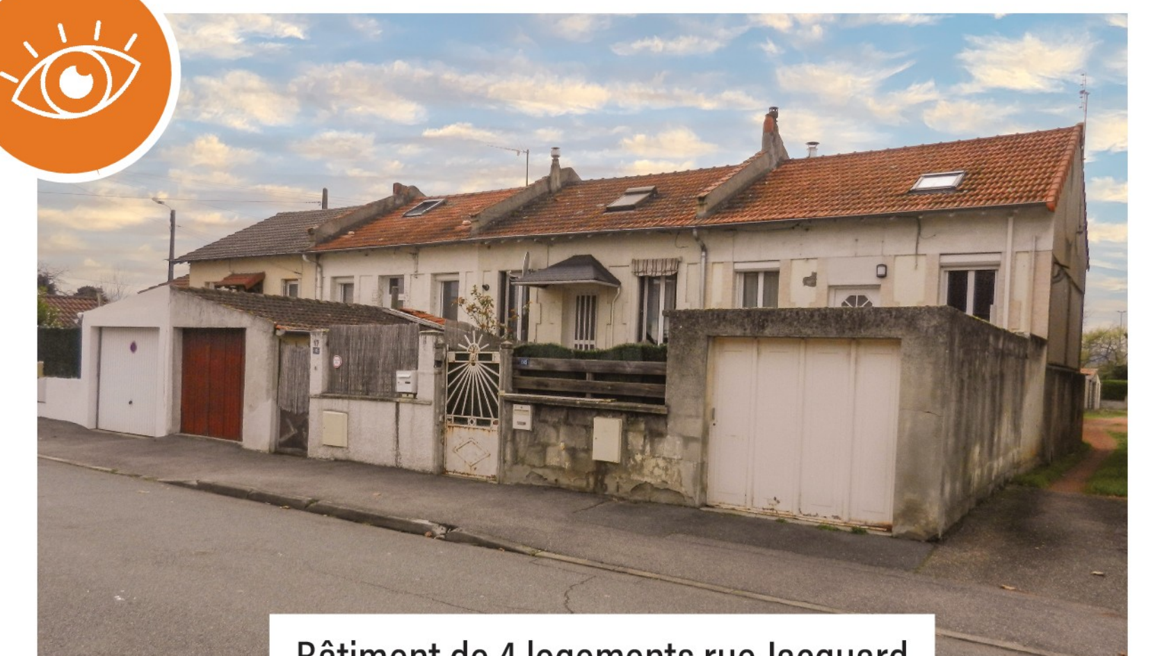
Bâtiment de 4 logements rue Jacquard
