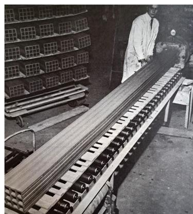
Test d'étrépage d'une tuile sur grand longueur pour vérification des déformations.
