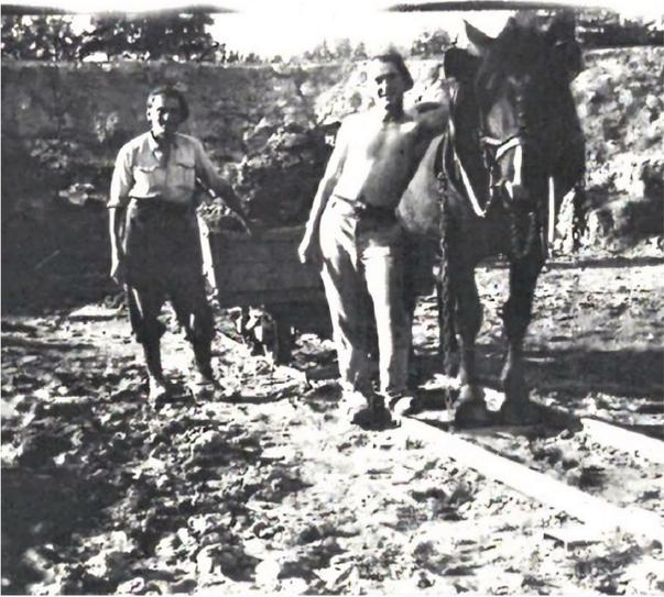
L'extraction de l'argile se fait à l'aide de barres à mine, de pioches et de pelles. La terre est ensuite transportée en brouette par les ouvriers ou en wagonnet tiré par un cheval sur des rails. Dans certaines tuileries, le cheval est remplacé par une petite locomotive sur un système de rails à voie étroite.
