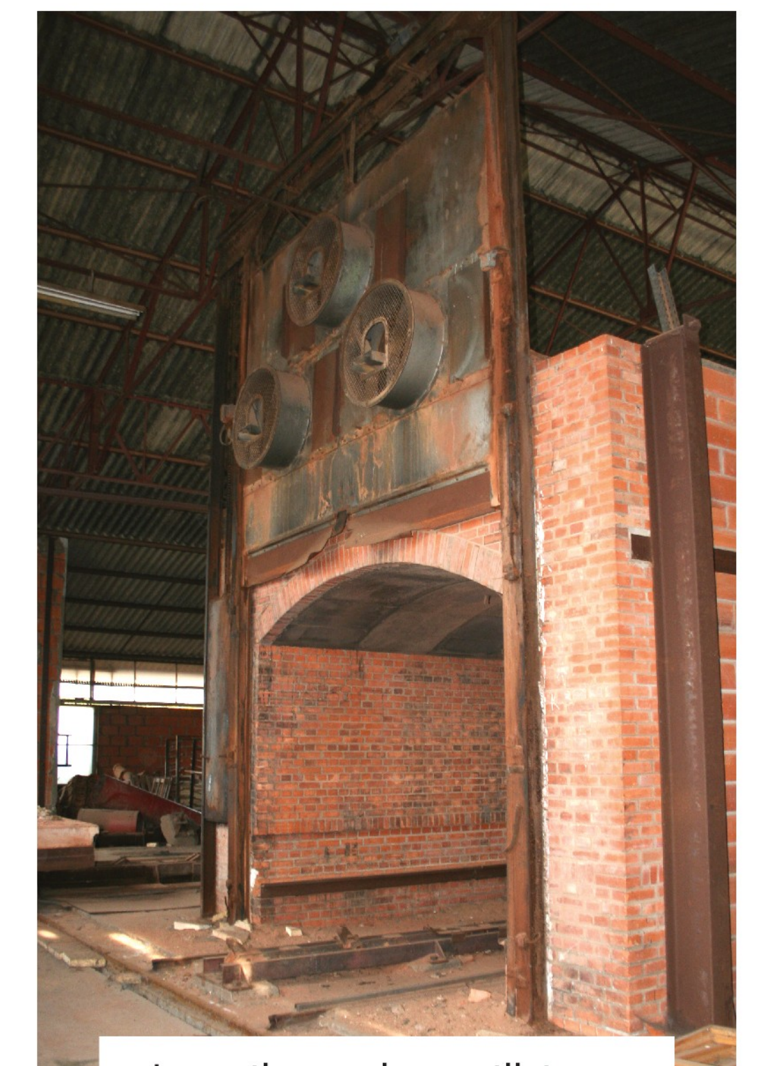
La sortie avec les ventilateurs
