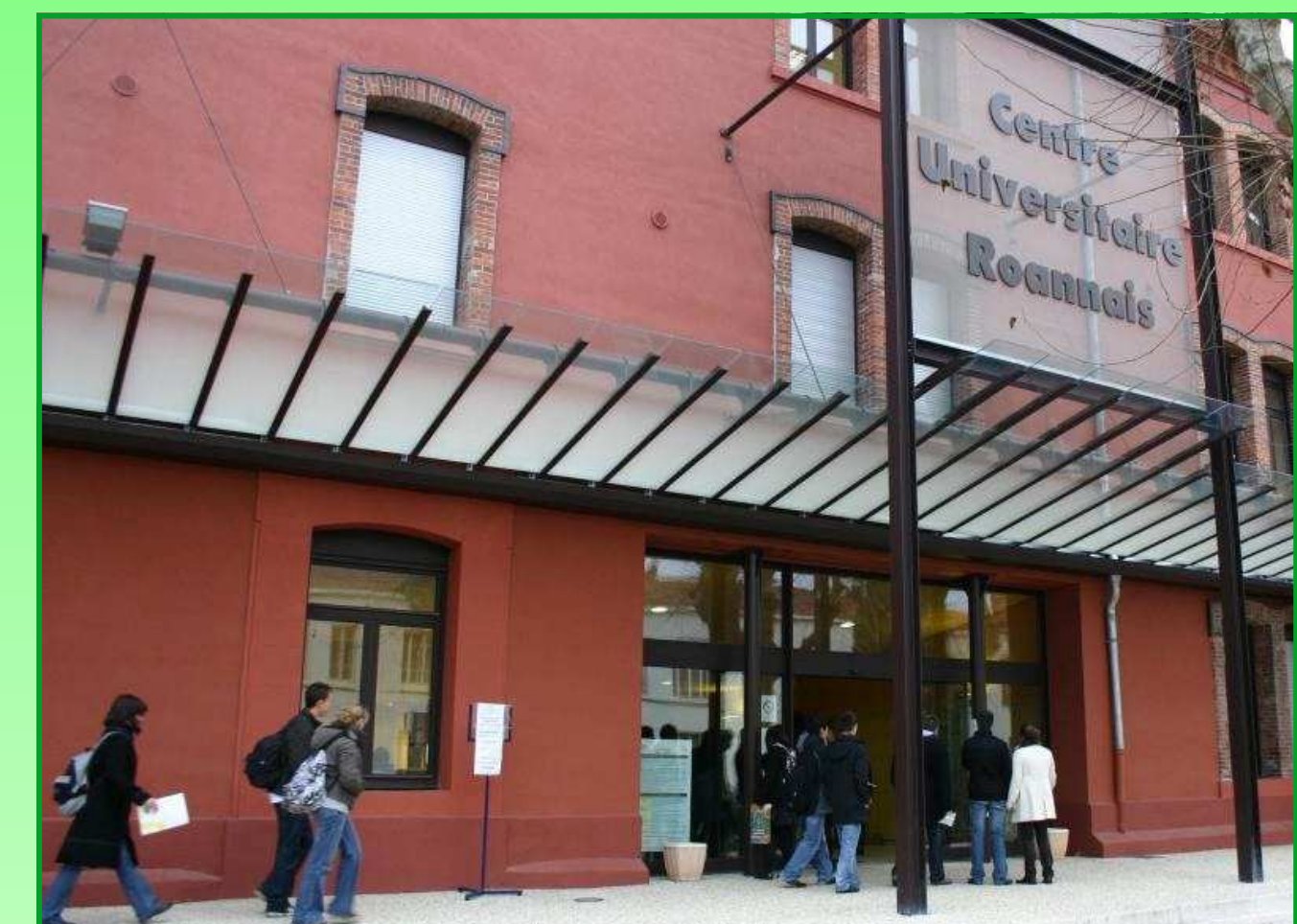
Réaménagement du Centre Pierre Mendès France - 2007
