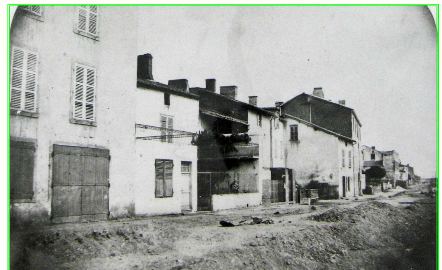
Assainissement général de la ville (bas quartiers surtout) : quai des Charpentiers...
